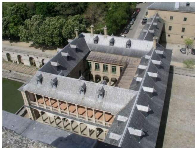
La enorme Casa para Destilar las Aguas vista desde la torre de la botica. El diseño original contaba con un gran número de chimeneas, que se fueron retirando en siglos posteriores al desmontarse el laboratorio
